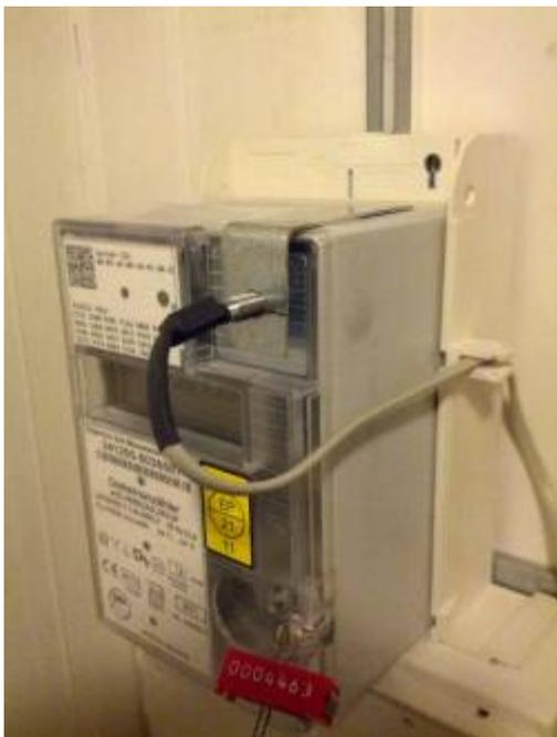
Falls der Stromzähler nicht zyklisch sendet, gäbe es noch die Möglichkeit zusätzlich einen IR-Sender mit an den Raspberry Pi anzuschliessen.
